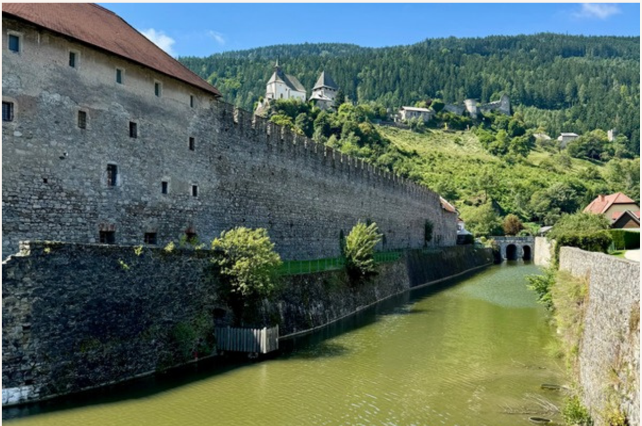
Foto: Wasserführender Stadtgraben in Friesach um 1300 © Carmen Heller
